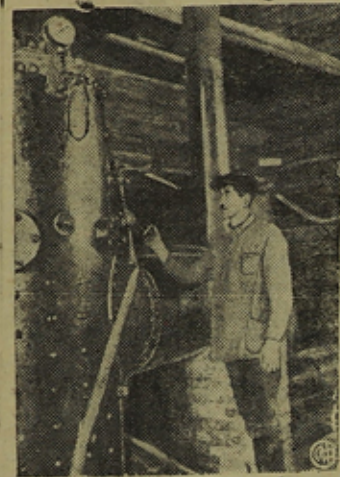
Колхоз „Красная Горка“ Уторгошского района построил в этом году скотный двор на 60 голов. При скотном дворе оборудован паровик для подачи воды на скотный двор. На с/заведывающий фермой т. КАЛИГИКОВСКИЙ регулирует подачу воды.
