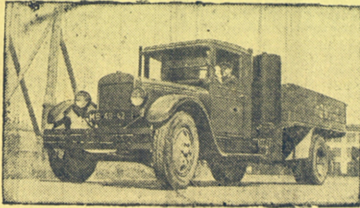
На снимке: Трехтонная машина ЗИС-5, с газогенератором Г-23.
