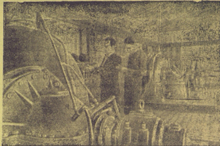
Сталинская водопроводная станция, построенная во второй пятилетке под Москвой, является самой мощной в Европе. На снимке: начальник насосной станции Г. В. Мягков и машинист-электрик П. А. Огурцов проверяют работу приборов. Фото Э. Евзерихина.
